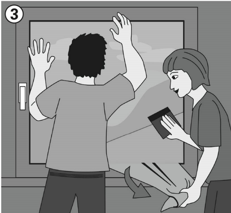
3 Schutzpapier entfernen und Folie anbringen.
